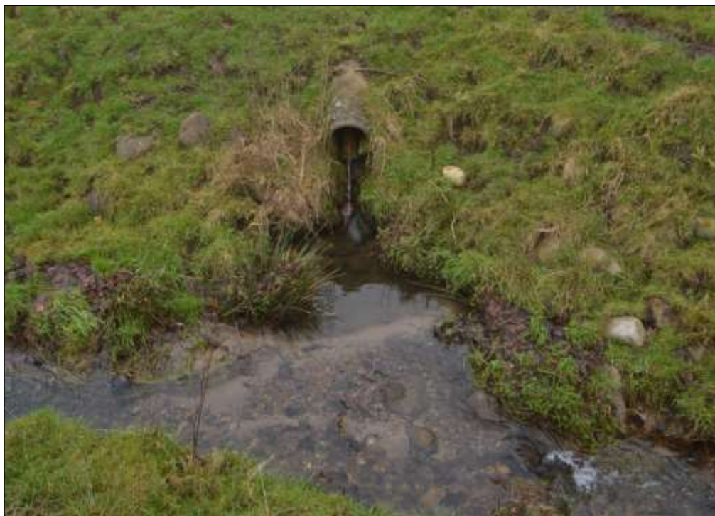
Figur 6. Fra besigtigelse d. 19. januar 2022. Udløbspunkt O20100U/O10000U, hvor der ses en lille lunke og sandaflejring.
